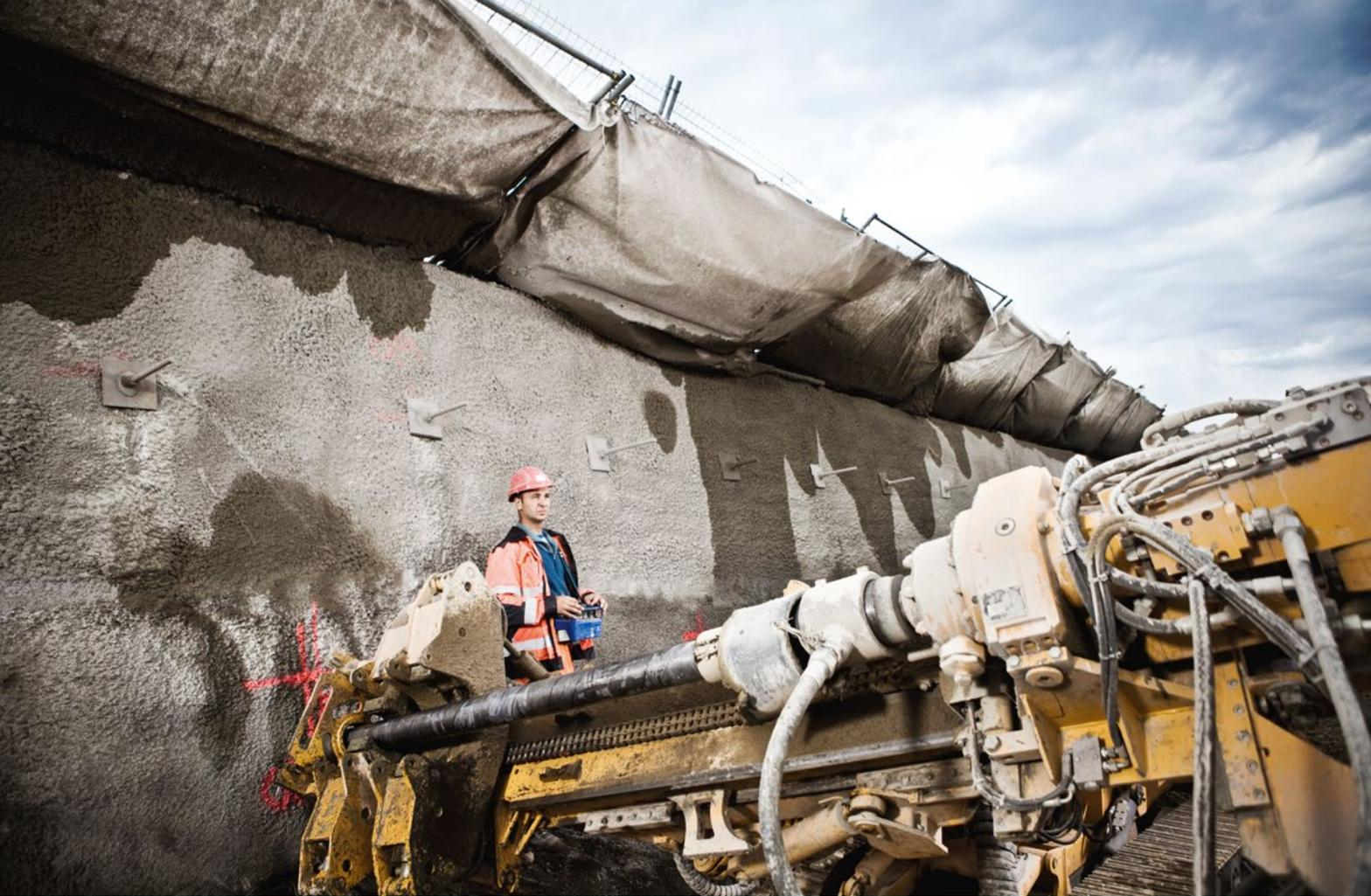
▲ Mit Bohrgeräten werden die Löcher für **Felsanker** durch die Wand in den Baugrund gebohrt.
