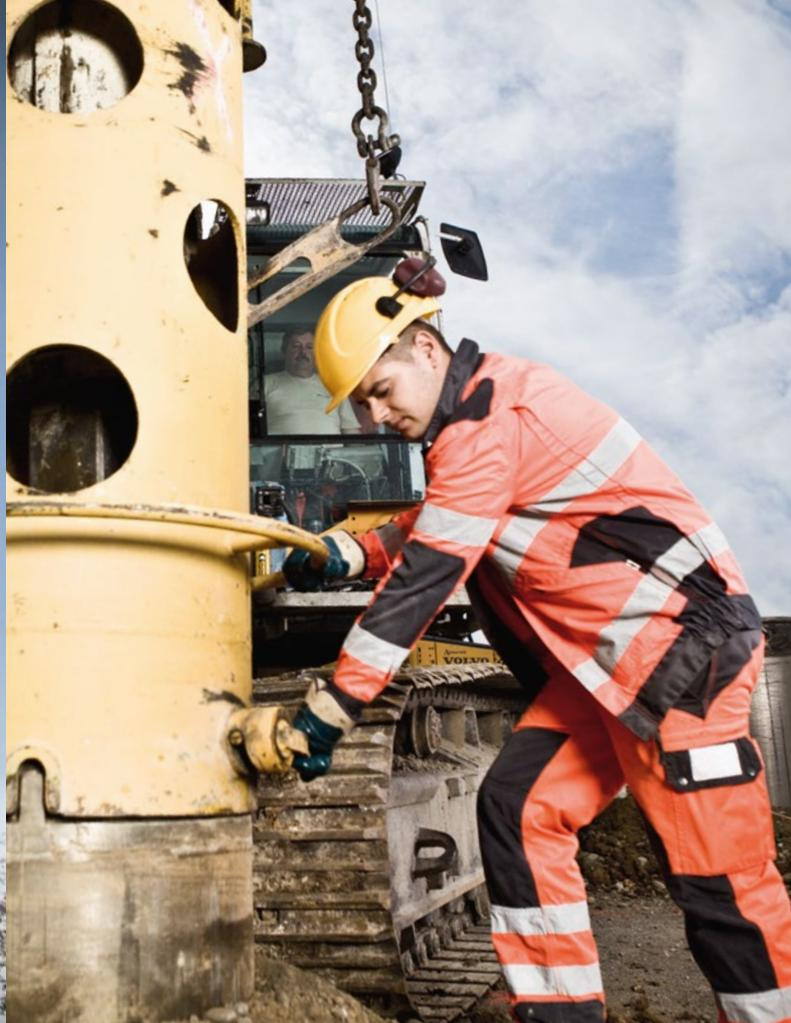
▼ Bevor es mit der Bohrung losgeht, wird jedes Bohrloch genau nach Plan eingemessen.
