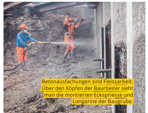
Eine Rühlwand entsteht.
